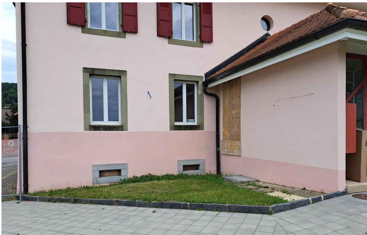
Emplacement de la rampe PMR
